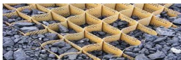
شکل ۴- یک ژئوسل قرار گرفته در بین خرده سنگ‌ها
