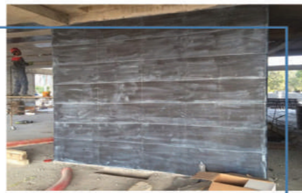
تقویت دیوار بتن آرمه
