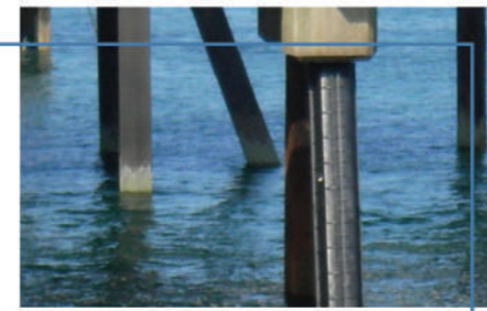
تقویت پایه پل مجاور آب
