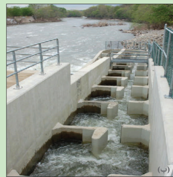
شکل ۴. الف) طرح مفهومی راه‌ماهی شکافدار قائم [۶]، ب) نمونه‌ای از راه‌ماهی شکافدار قائم
